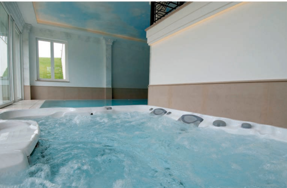
Der bereits existierende Whirlpool wurde mit in die Anlage integriert und ist an die Aufbereitungstechnik des Pools angeschlossen. Per Knopfdruck wird das Whirlpoolwasser aufgeheizt und das Becken ist badefertig.
