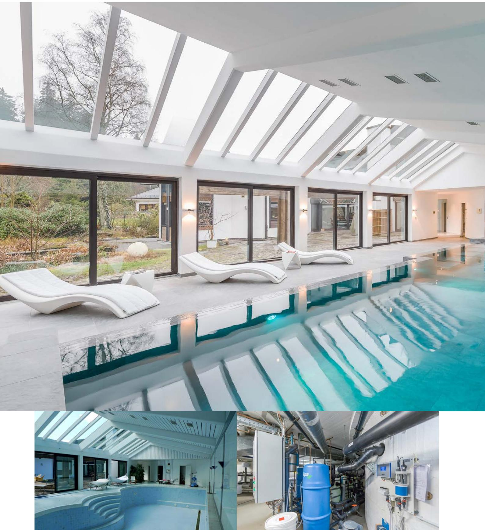
Die Rundungen, die den früheren Pool ausgezeichnet haben, wurden entfernt und praktisch ein neues Becken in die Betonwanne eingebaut.
